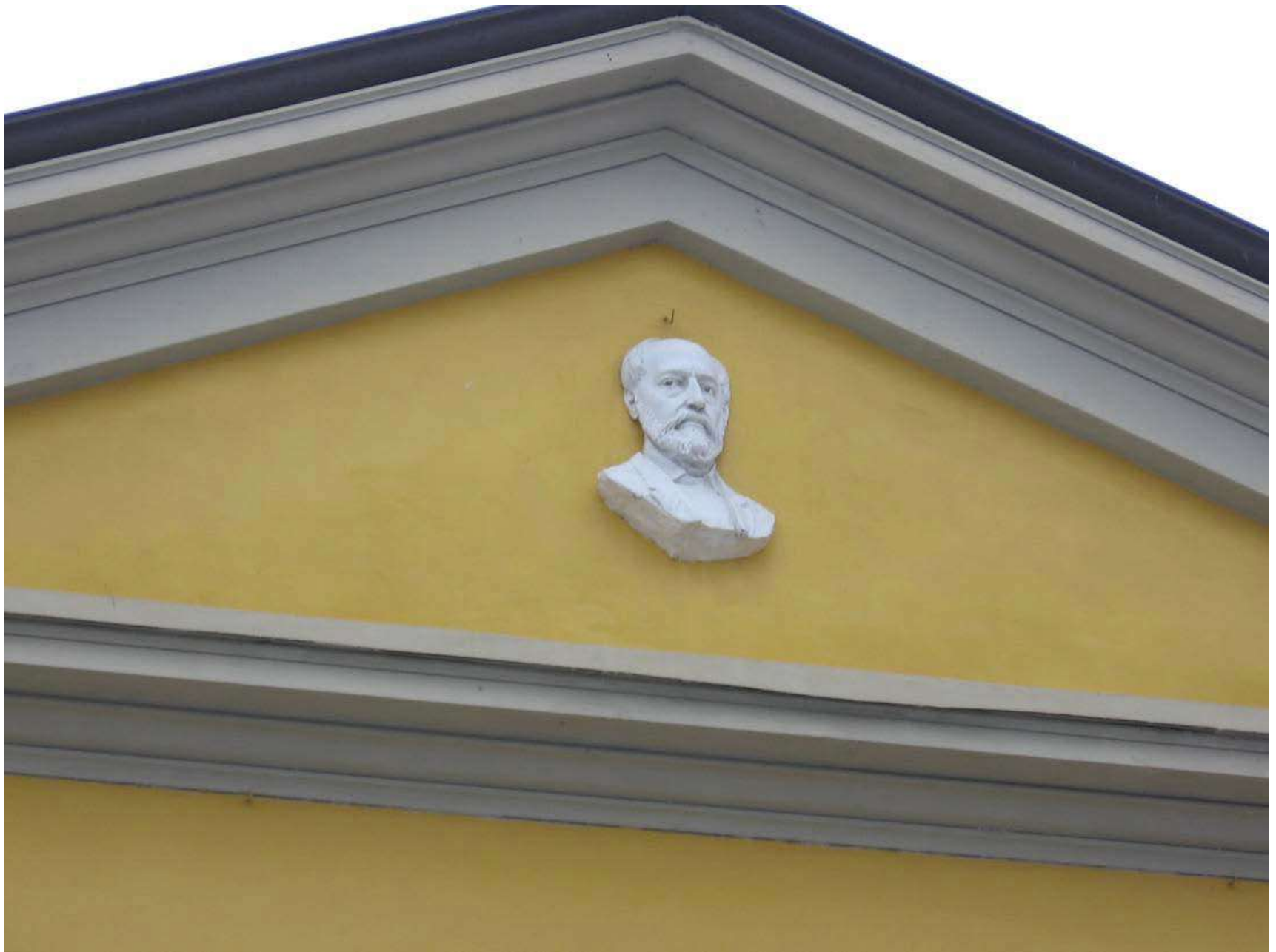
(3.2.2 V) Il cornicione esterno appare efficacemente ancorato alla muratura - il fregio è ancorato alla struttura
